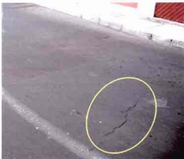
Fotografía N° 4: Fisura trasversal
