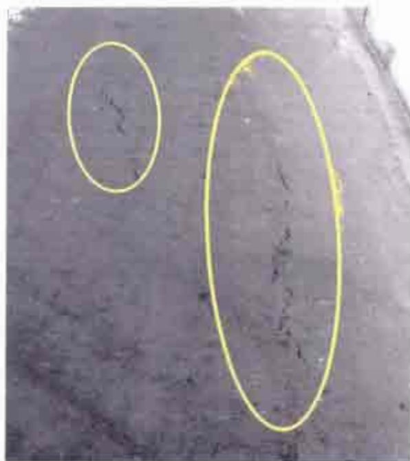
Fotografía N°6: Fisura longitudinal
