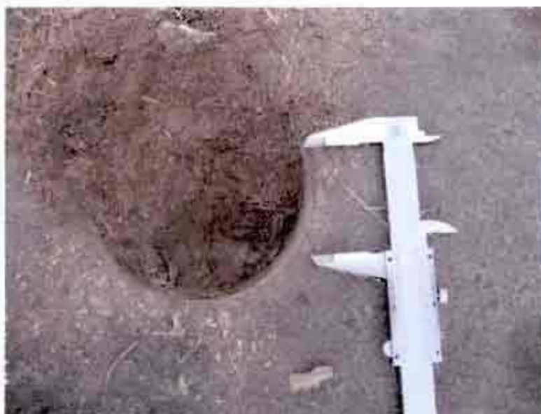
Fotografía N° 2: Agujero causado por la extracción de testigo
