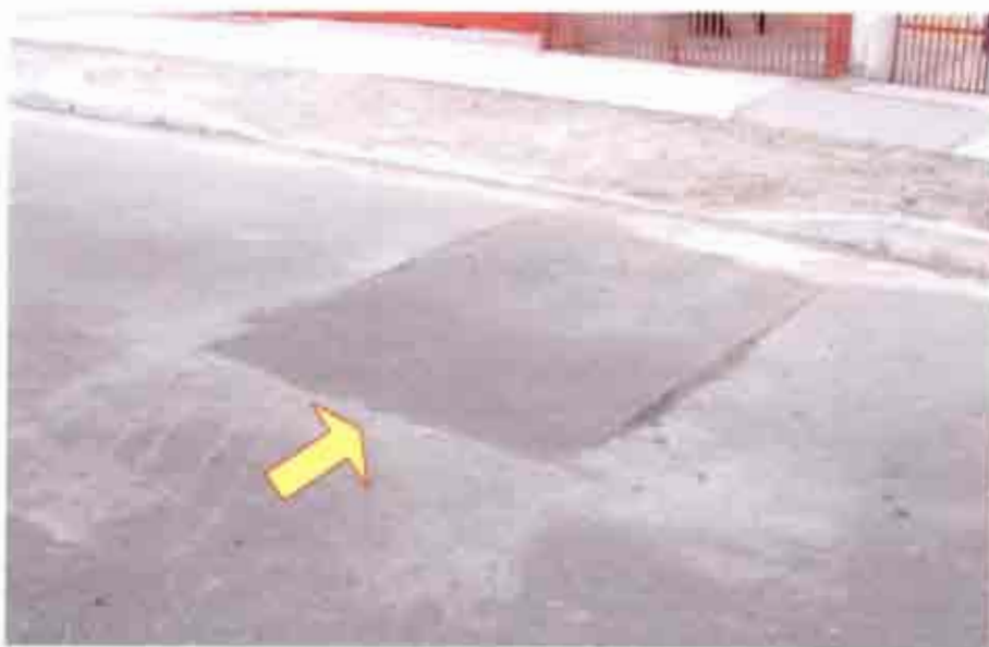
Fotografía N° 20: Intervención del pavimento con reparación.
