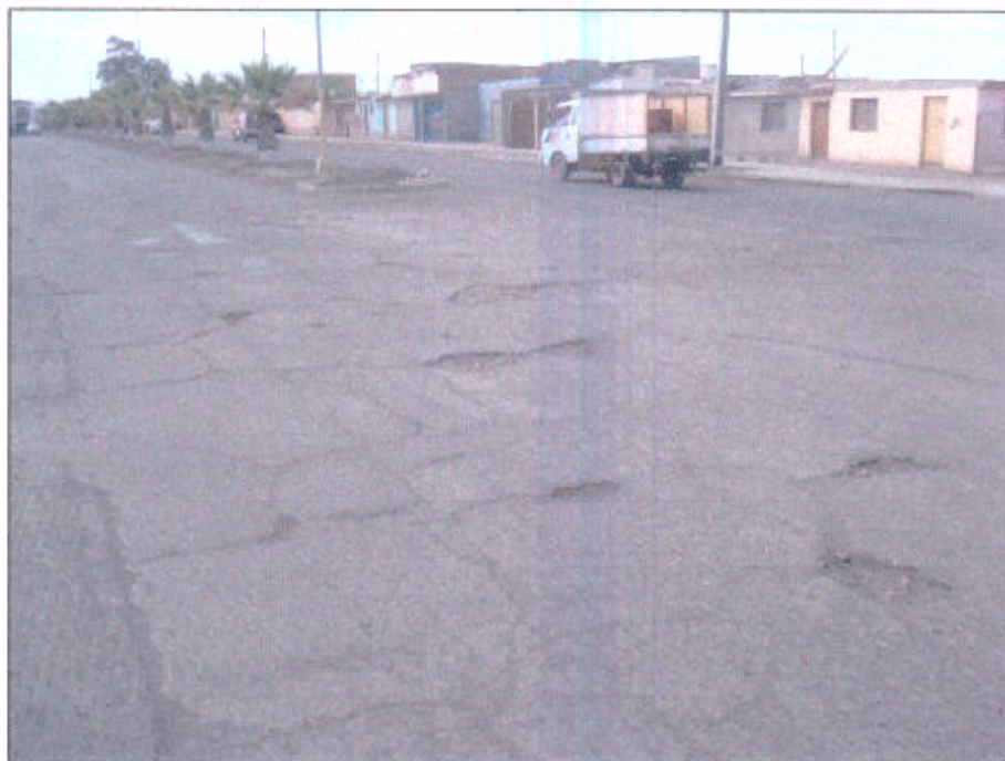
Fotografía 1: Avda. Gonzalo Cerda
