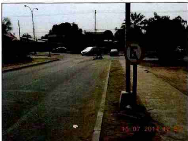
Foto N° 5 Señalización con cubo de hormigón como lastre.
