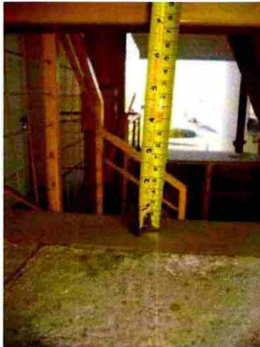
Fotografía 14: Distancia, losa-perfil inferior baranda.
