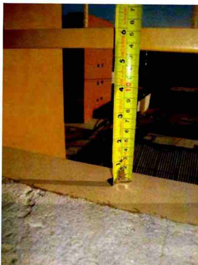
Fotografía 15: Distancia, losa-perfil inferior baranda.
