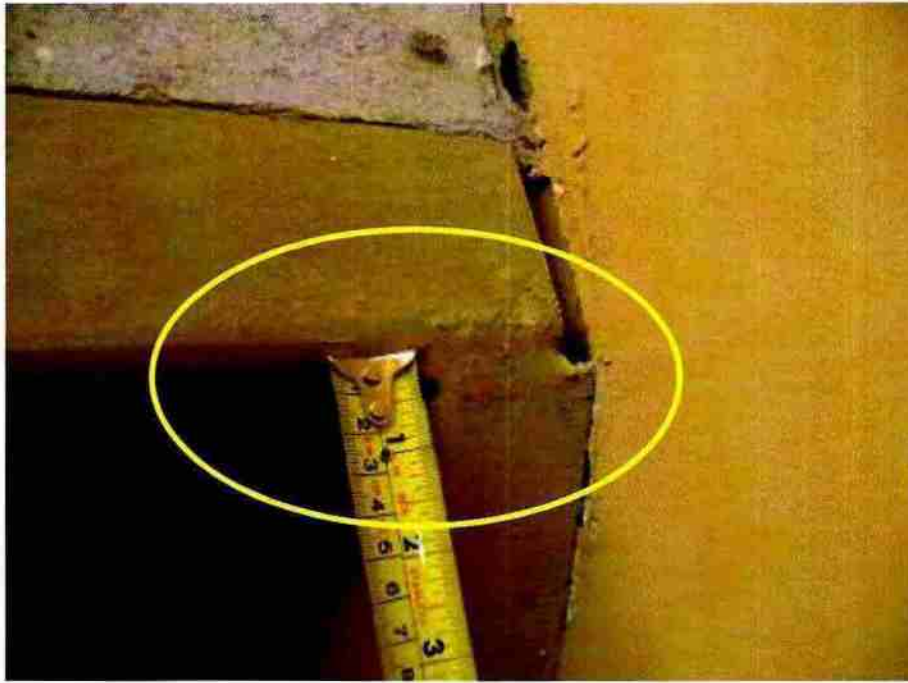
Fotografía 13: Unión limón con losa descanso, soldadura de 1,5 cm.
