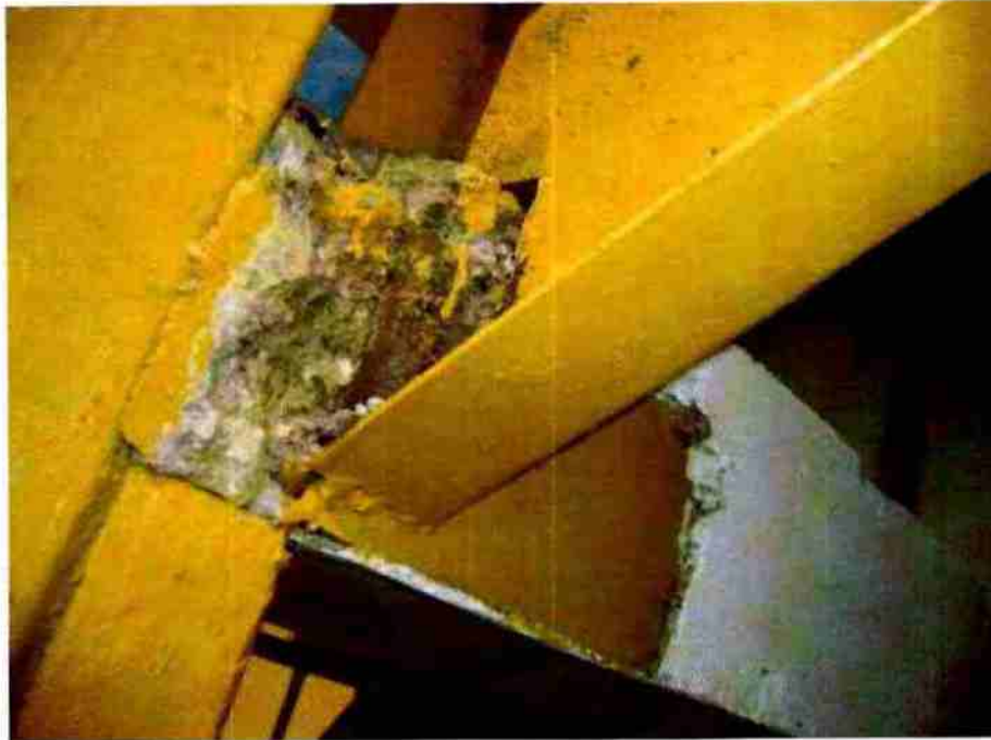
Fotografía 9: Unión base limón con losa, vista inferior.
