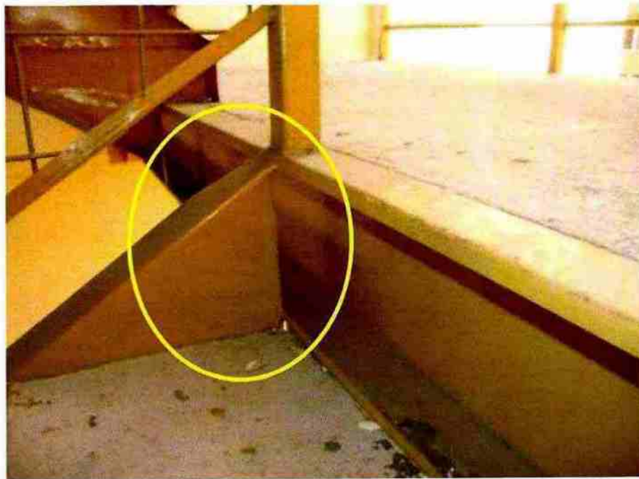
Fotografía 12: Unión limón con losa descanso.
