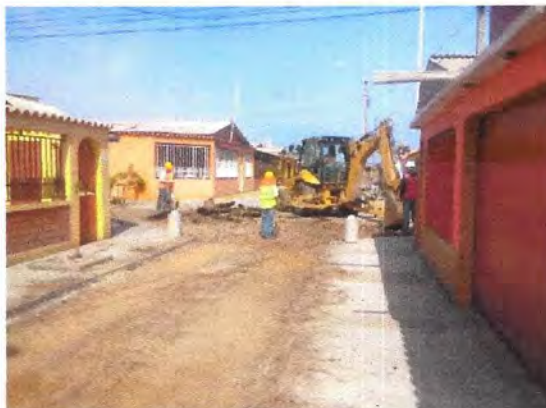
Fotografía N° 2, retiro de asfalto.
