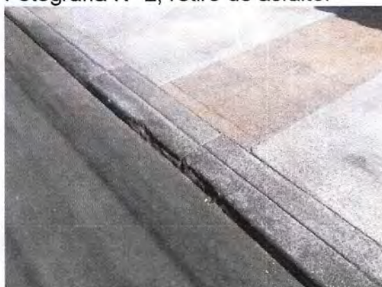
Fotografía N° 4, solera dañada.
