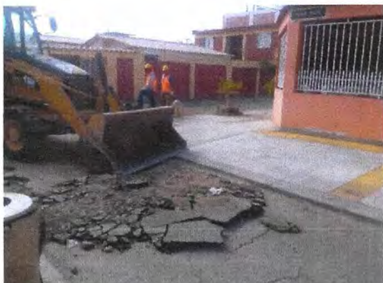
Fotografía N° 1, retiro de asfalto.
