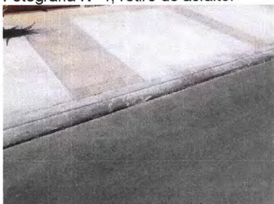
Fotografía N° 3, solera dañada.
